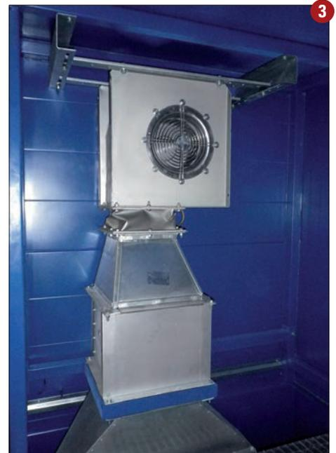
**Riscaldamento elettrico a ricircolo d'aria con regolatore di temperatura digitale**
