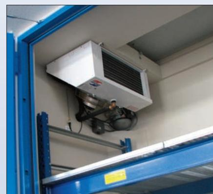
Unità di raffreddamento Split (vista dall'interno) in versione antideflagrante in un sistema di controllo della temperatura per sostanze infiammabili.
