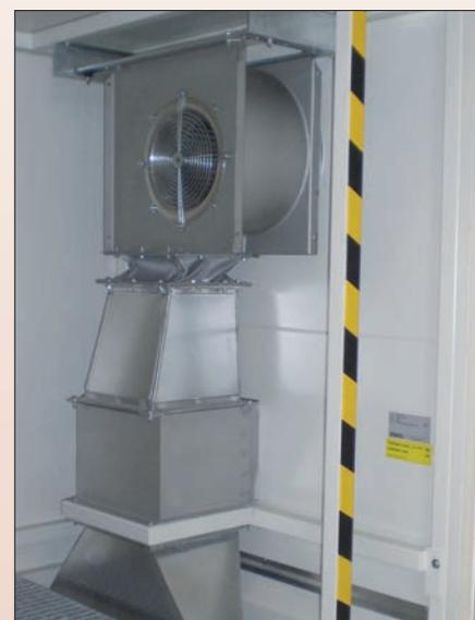
Riscaldatore interno con ventilatore di ricircolo, condotto di scarico dell'aria, non antideflagranti
