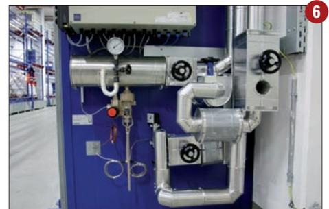
1. Riscaldamento a vapore con controllo meccanico della temperatura
